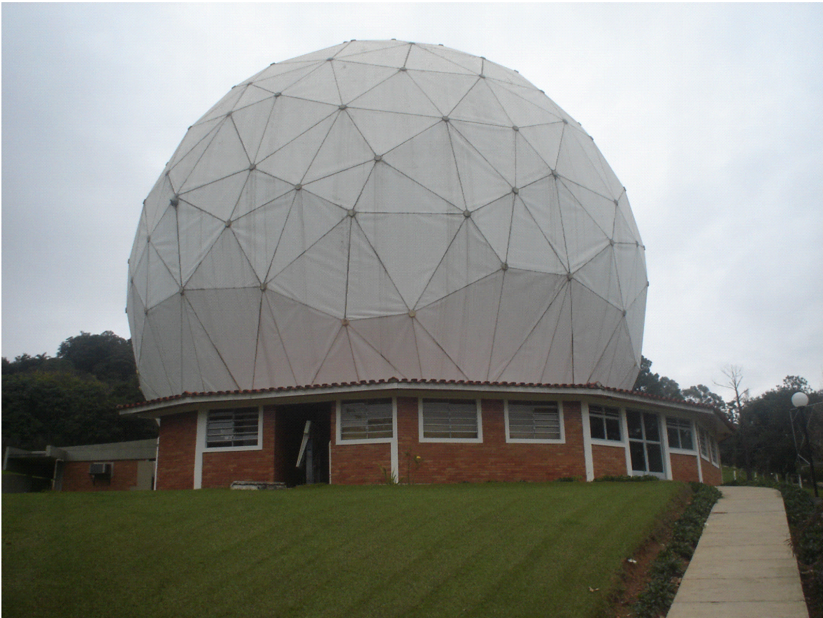
Figura 3.1.1 - Estrutura da redoma que contém a grande Antena de Itapetinga.
